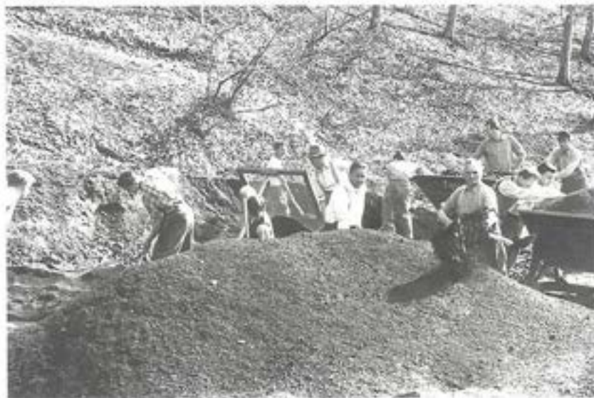
Die Aschenbahn ist im Entstehen
