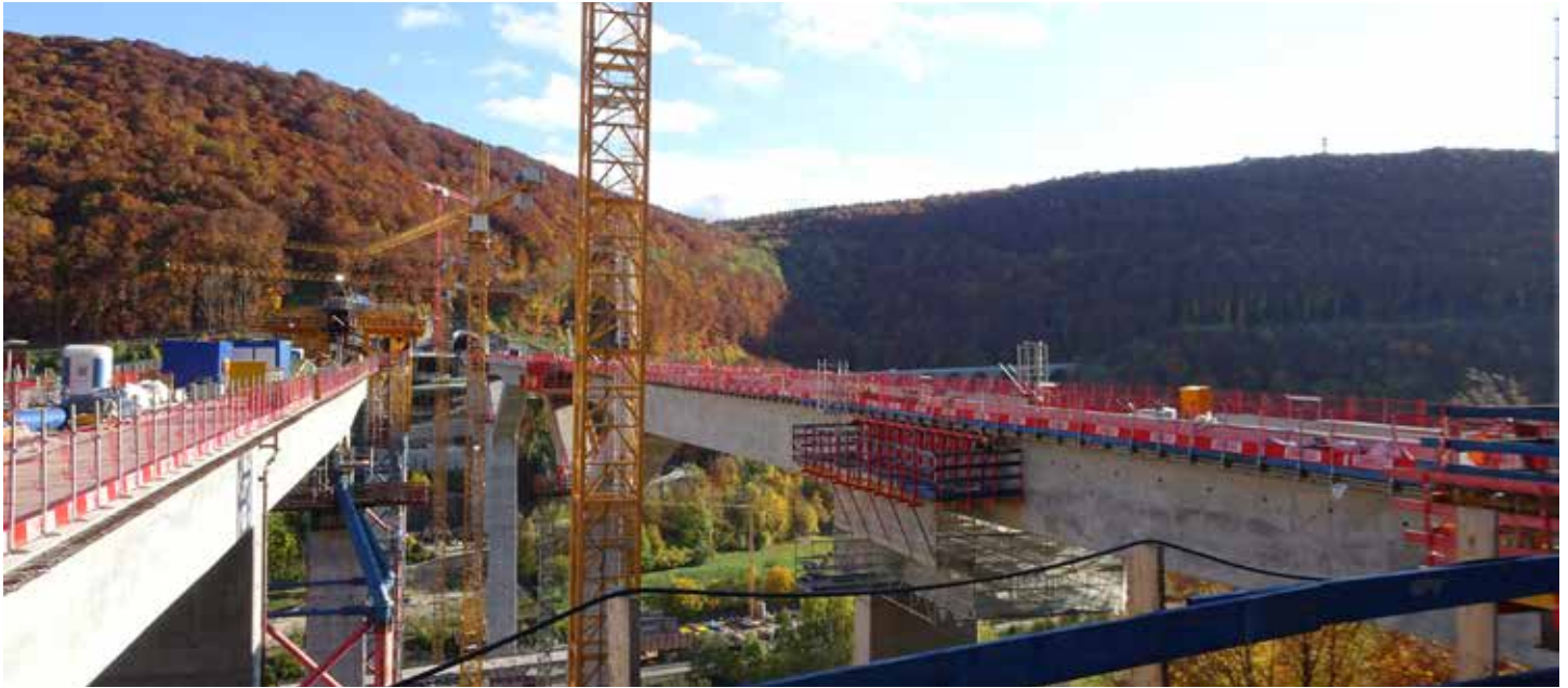
Blick von der noch im Bau befindlichen Filstalbrücke
